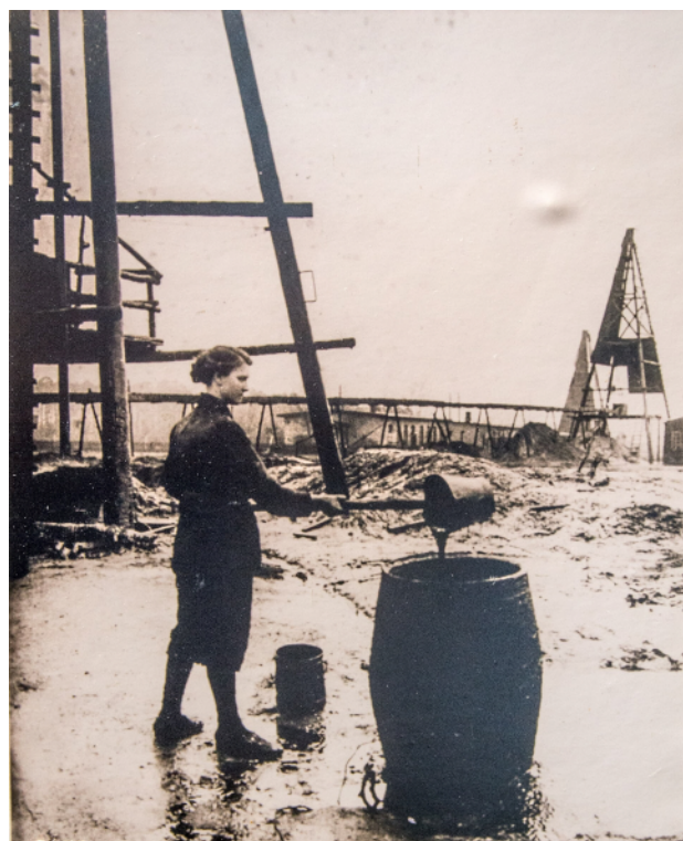
Dora Weiland (1892-?) En la imagen de Wietze se ve cómo se utiliza un cucharón manual para llenar barriles con el aceite que se ha acumulado en los fosos. Autor desconocido - Deutsches Erdölmuseum Wietze ( Erdöel Museum ), CC BY 2.5, Link .
